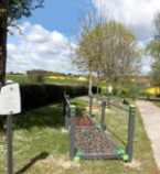
A droite passage sur sols meubles version corde et chaîne alternée d'une main courante en inox.
