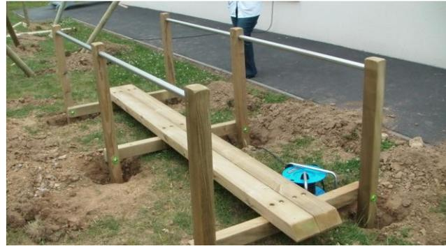
Déposez l'agrès dans les trous, caliez-le de niveau en vous assurant que les vis à embouts torx indique bien le niveau fini du sol (ces vis sur chacun des pieds indiquent le niveau zéro à respecter). Une fois de niveau, redonnez un coup de clés sur chaque écrous et posez les bouchons de sécurité. Concernant le scellement, chaque agrès doit être fixé au sol.
